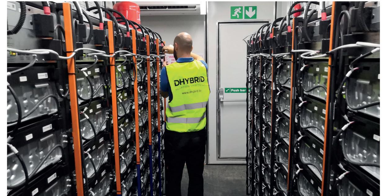
Mit einer Kapazität von 1.027 kWh überbrücken die Lithium-Ionen-Speicher die Nächte und sonnenarme Tage
