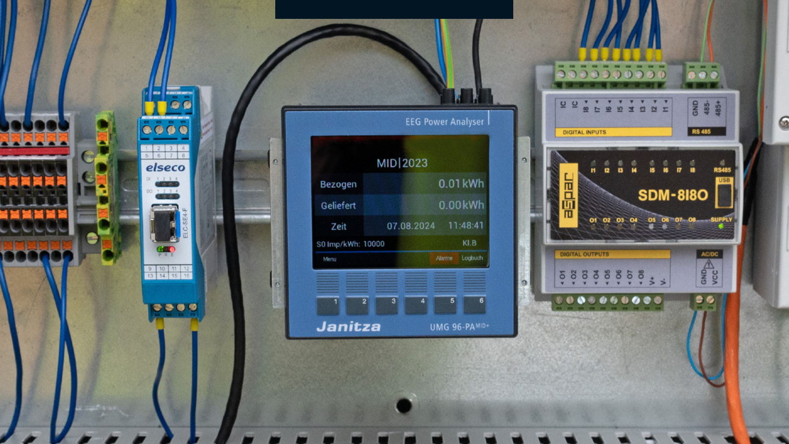
UMG 96-PA-MID+ registra los valores medidos en la estación transformadora del parque fotovoltaico de conformidad con la Directiva 2014/32/UE de la UE
