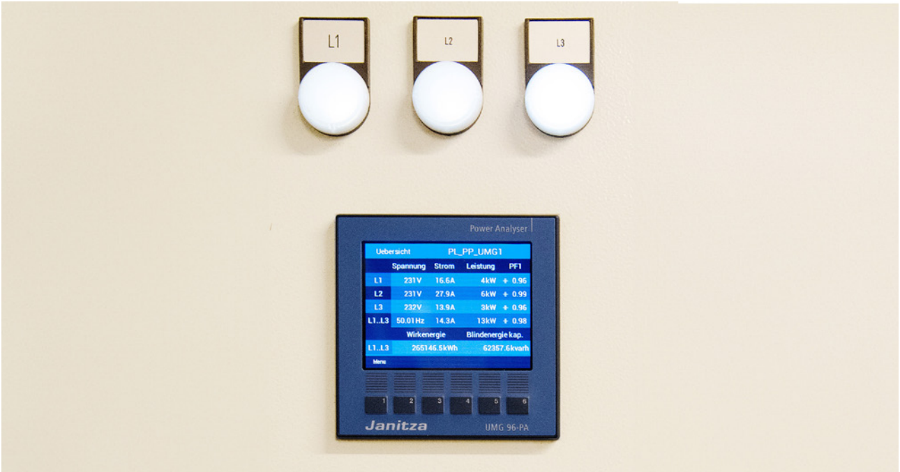
Los analizadores de red UMG 96-PA de Janitza sustituyen a los antiguos dispositivos de montaje en panel
