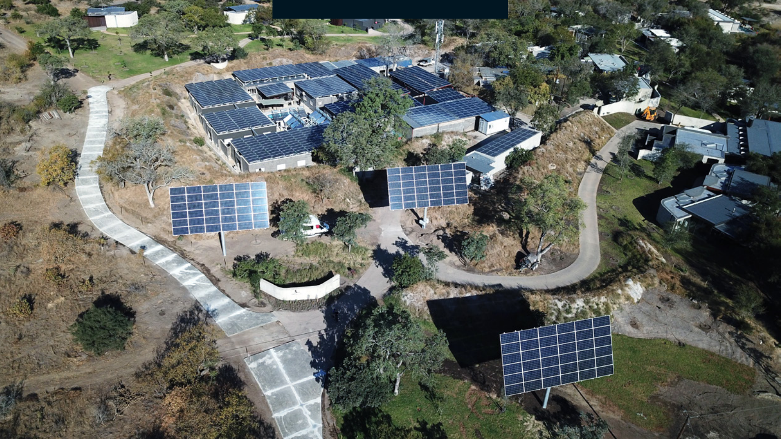
Se han instalado sistemas fotovoltaicos de 260 kWp en los aparcamientos y en los alojamientos de los empleados
