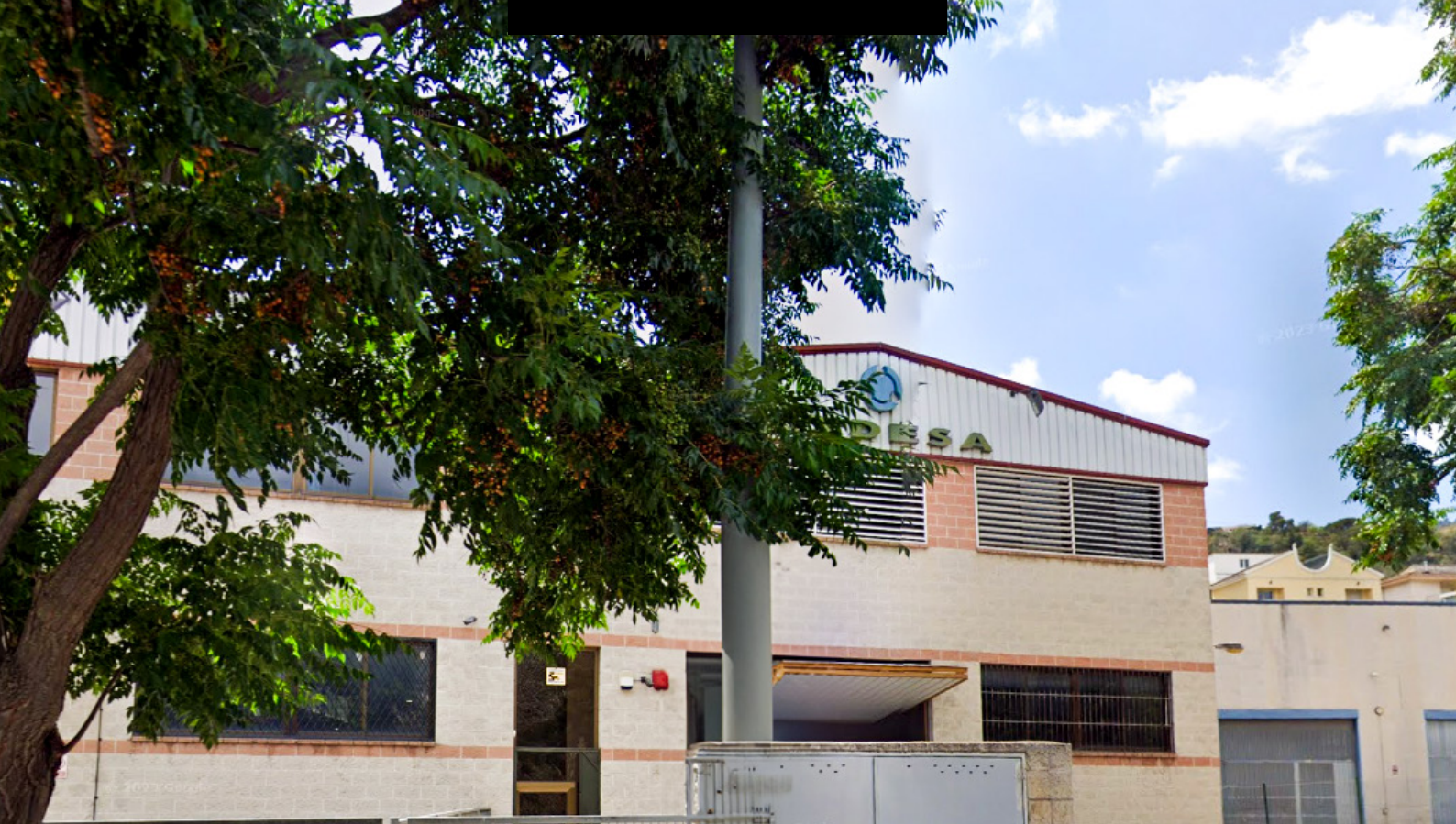
Ein Teil der Anlage von CITRESA in Carcaixent, Valencia
