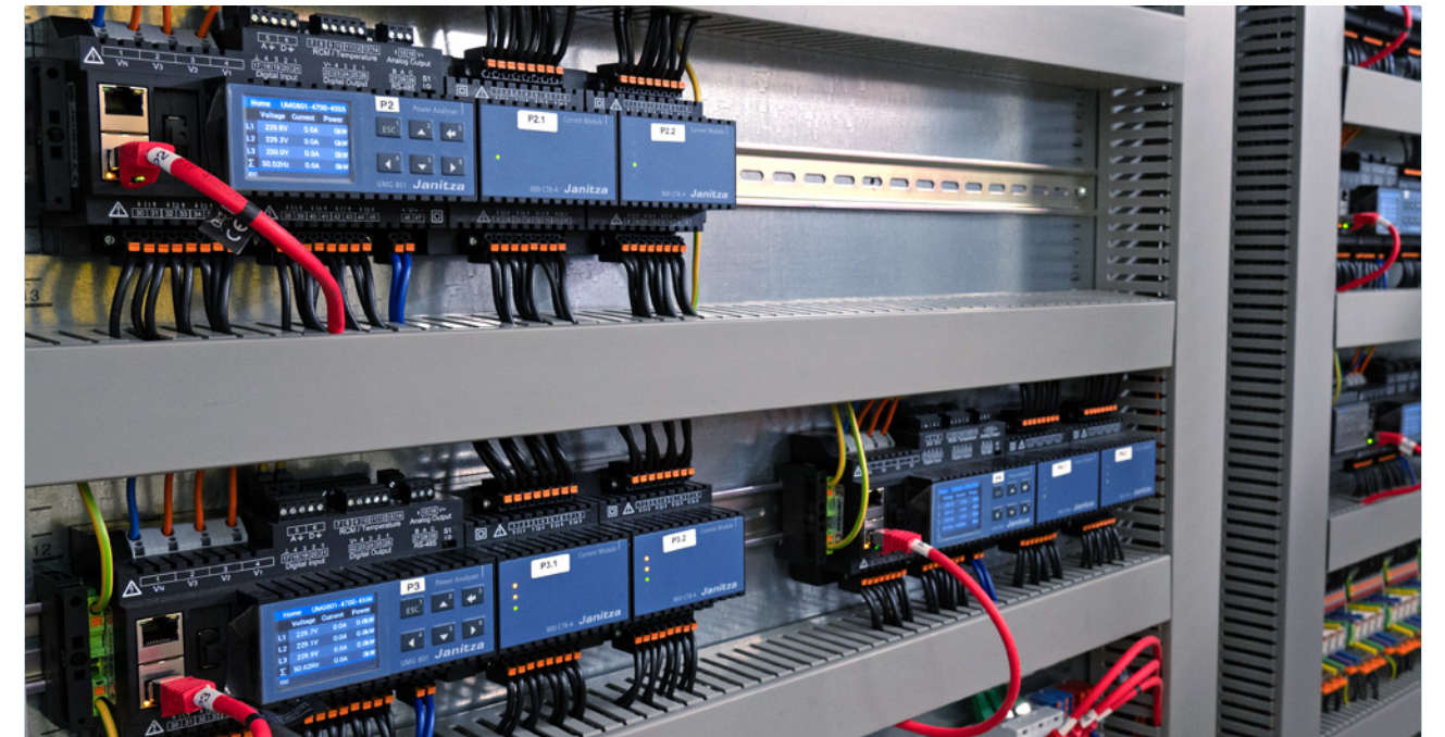
Janitza Messgeräte UMG 801 sind mit Modulen erweiterbar.
