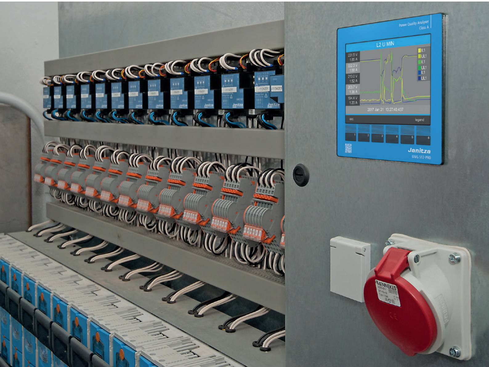
Técnica de medición instalada en un centro de transformación con el UMG 512-PRO como dispositivo maestro al lado de los esclavos UMG 103 para las salidas.
