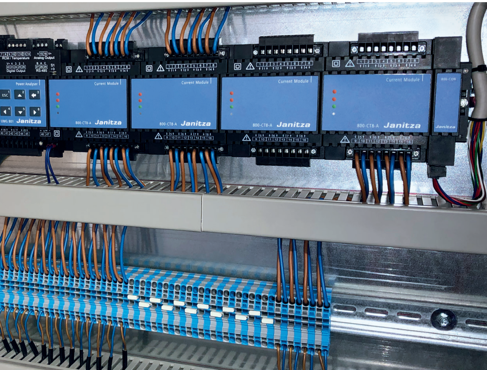
Centro de transformación: medición de un transformador, todas las salidas inclusive (UMG 801 y módulos)
