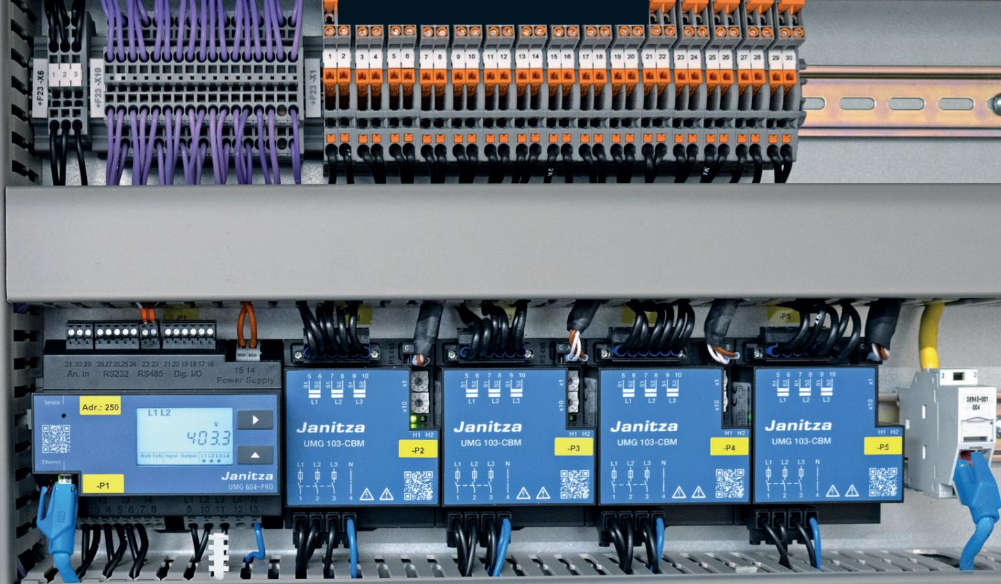
Eine bewährte Kombination: Der Netzanalysator UMG 604-PRO zusammen mit Energieanalysatoren UMG 103
