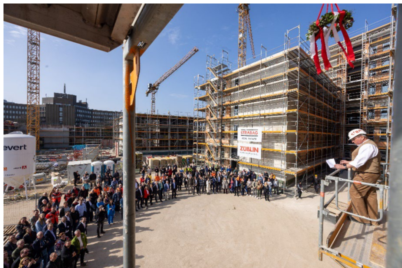
Richtspruch: Richtfest MONA auf dem H3ö Campus Hannover
