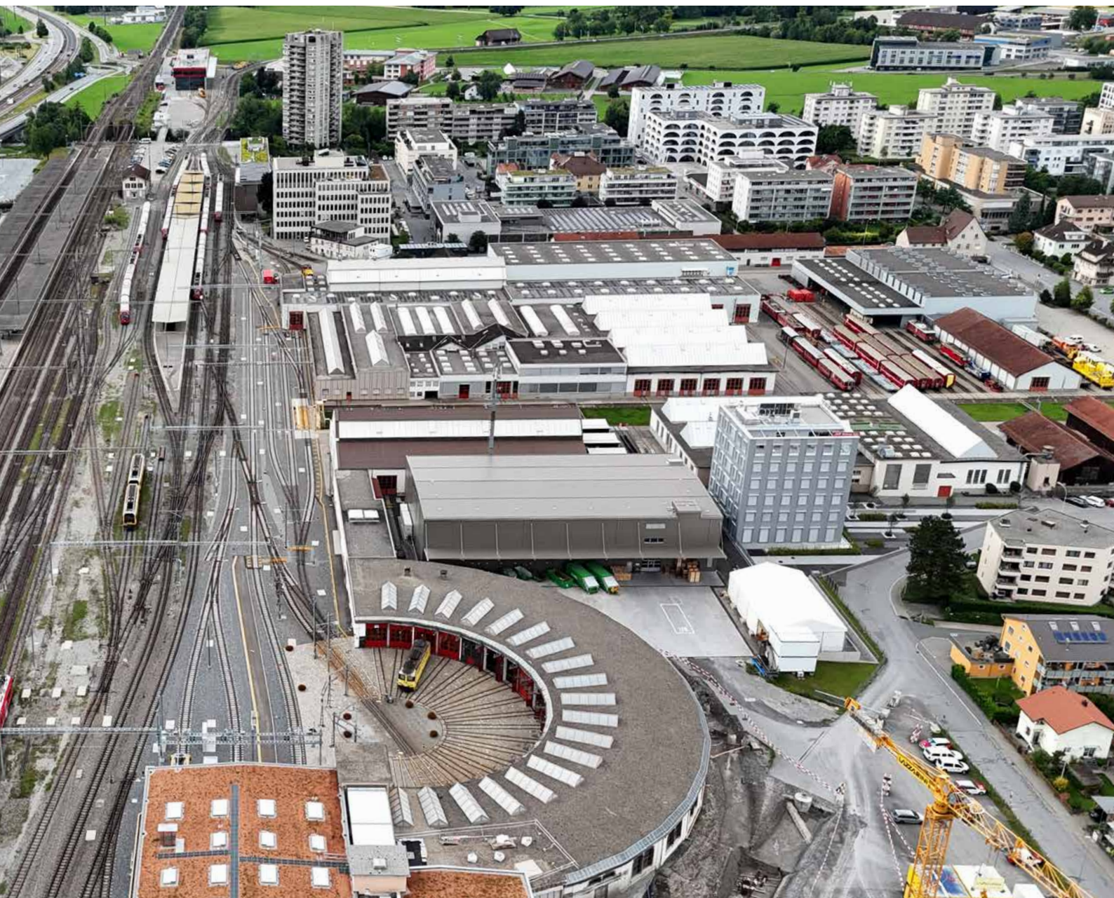
Neues Zentrallager und Bürogebäude in Landquart
