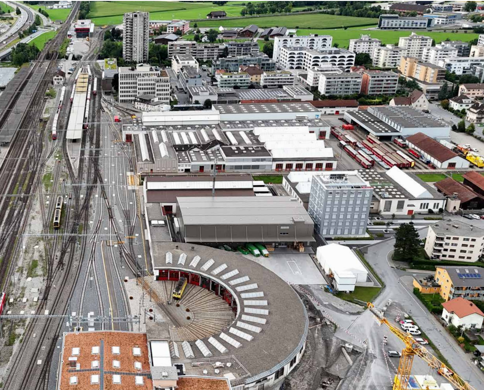
Neues Zentrallager und Bürogebäude in Landquart
