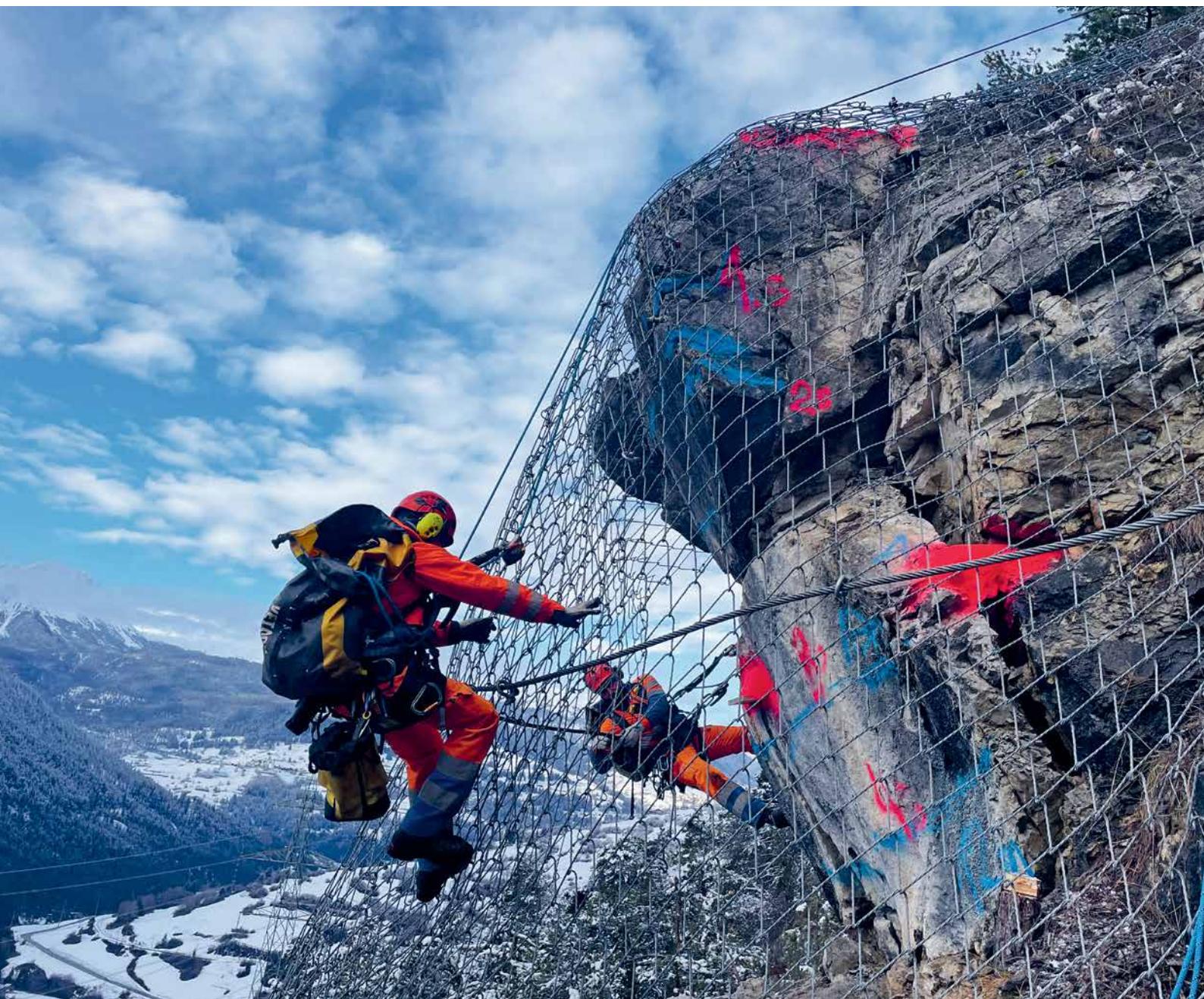
Felssicherung oberhalb von Surava
