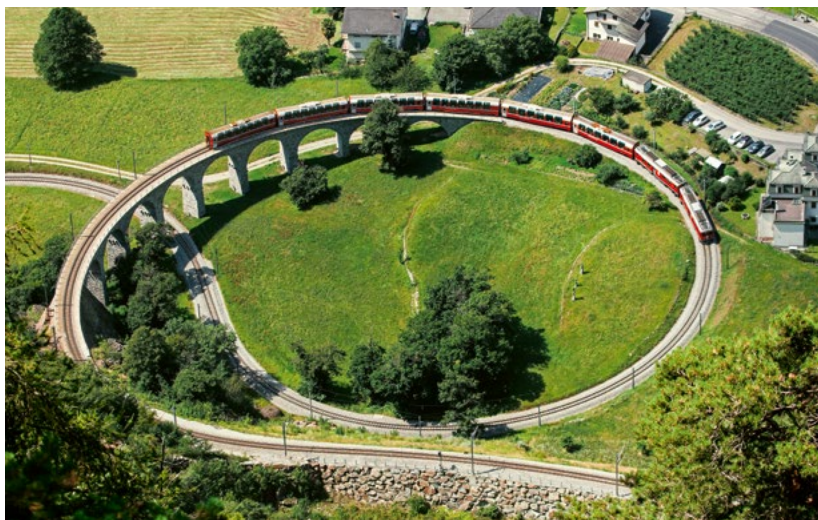
Kreisviadukt/Brusio, 780 m ü. M. 11
