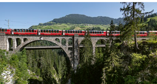
3 Solisviadukt/Solis, 863 m ü. M.
