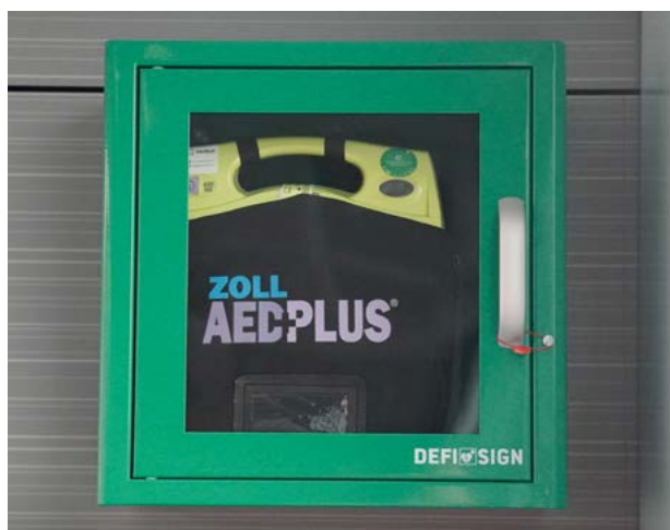
Bild oben: SOS-Sprechstelle mit Hinweisschild. Bild unten: AED-Wandschrank im Niederflerbereich.
