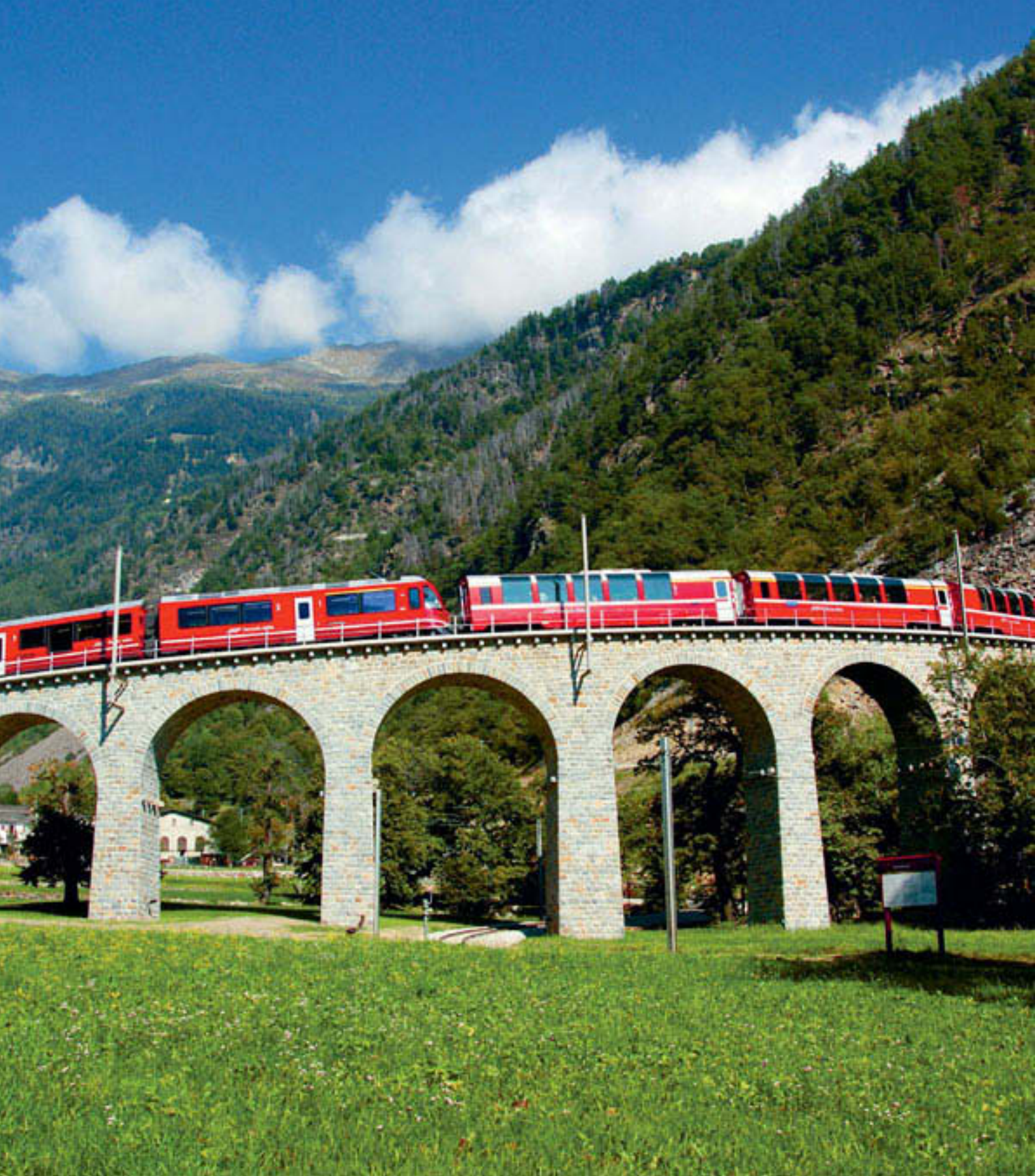
Der sanierte Kreisviadukt Brusio
