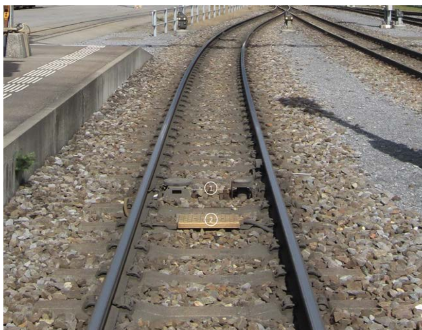
Bild oben: Risiken, die durch einen über das Ende seiner Fahrstrasse hinausfahrenden Zug entstehen, werden (soweit nicht vernachlässigbar) mit einem Durchrutschweg reduziert. Dieser ist hinter dem Ende der Fahrstrasse vorzusehen.
