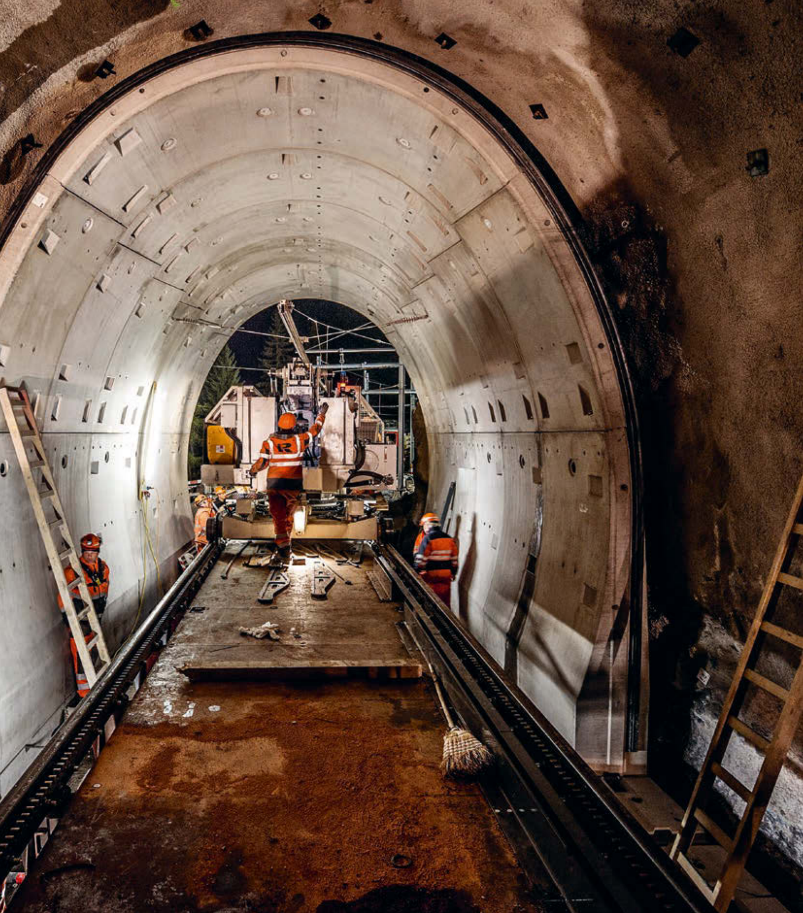
Glatscherastunnel Instandsetzung mit Normalbauweise
