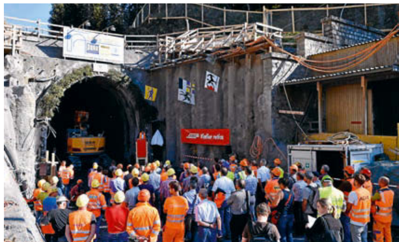
Anschlagfeier Neubau Albulatunnel
