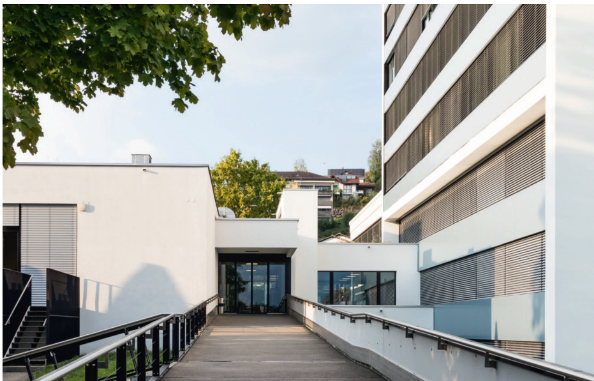
Ein Meilenstein war die Inbetriebnahme des sanierten Teils des Hauptgebäudes Mitte September 2020.
